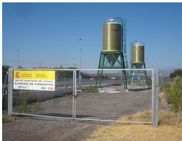
Figura 4. Silos de fundentes de 60 T
