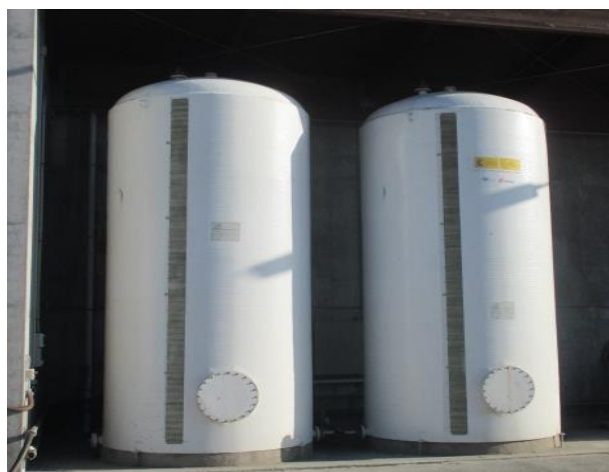
Figura 6. Depósitos de salmuera
